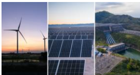
Hybride sol- og vannkraftverk
